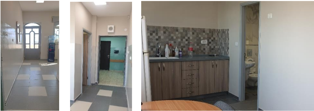
إعادة تأهيل وتقطيع غرفة استراحة المعلمات - بعد التنفيذ
