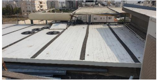
أعمال عزل التغطية القائمة والسطح لطابق مختبر الحاسوب (قبل وبعد التنفيذ)
