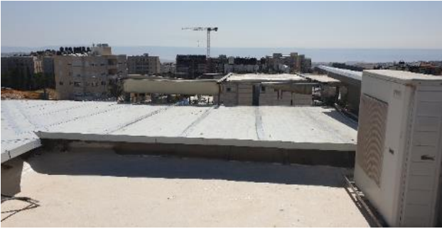
أعمال عزل التغطية القائمة والسطح لطابق مختبر الحاسوب (قبل وبعد التنفيذ)
