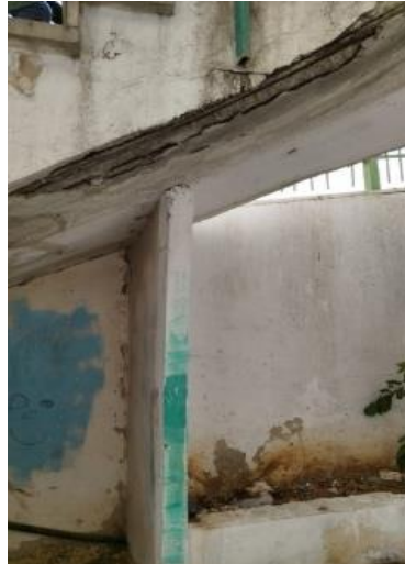
أعمال تدعيم الدرج الرئيسي للمدرسة (قبل وبعد التنفيذ)
