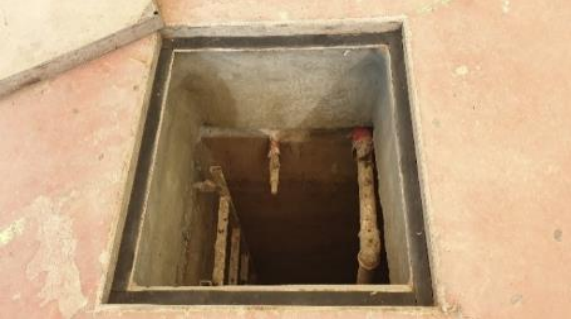
أعمال صيانة البئر بعد إلغاء خط التهوية وعزل الغطاء الخاص به
