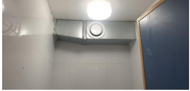
أعمال التهوية داخل الوحدات الصحية في الطابق الأرضي
