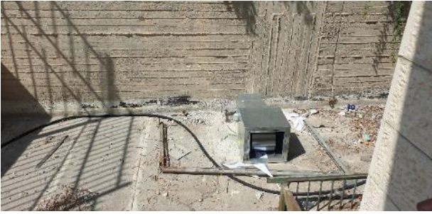
والوحدة الخارجية نظام التهوية الخاص بتلك الوحدات الصحية
