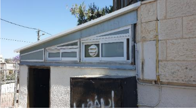
أعمال استبدال التغطية المعدنية للوحدات الصحية الخارجية وتركيب تهوية
