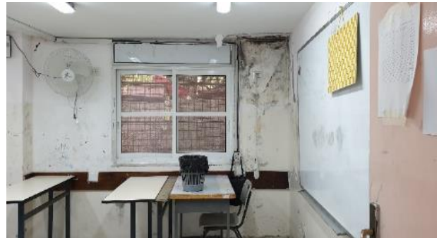
من أعمال طراشة الغرف الصفية ومعالجة أماكن الرطوبة فيها (قبل وبعد التنفيذ)
