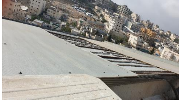
استبدال التغطية القديمة بأخرى جديدة لمختبر الحاسوب (قبل وبعد التنفيذ)
