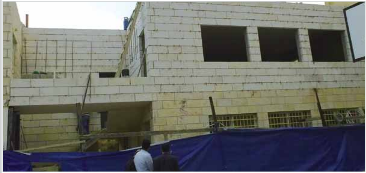
أثناء أعمال إنشاء مختبر العلوم في المدرسة الاورثوذكسية
